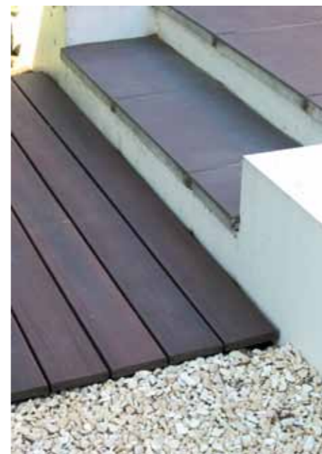
De keramische tegels van het eettafelterras hebben dezelfde tint als de composiet planken van de vlonder, zodat er een eenheid ontstaat. De tint van het Yellow Sun split sluit hier goed bij aan. De keerwanden van het terras zijn glad afgewerkt met een witte stuclaag. De brede witte rand rondom het terras accentueert de vorm.
