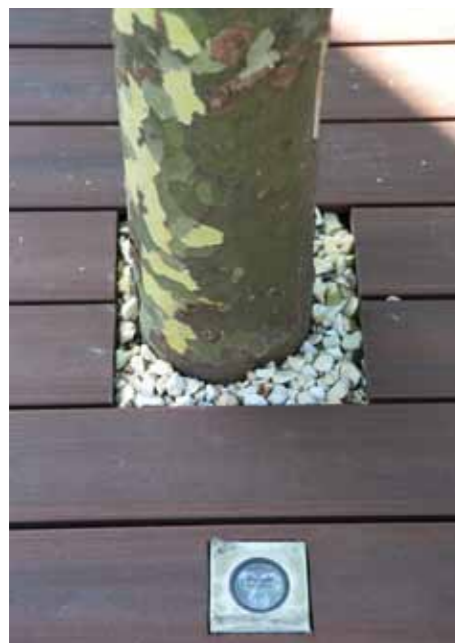
Elke plataan wordt van onderen aangelicht door een in de vlonder geïntegreerde grondspot. Rondom de stam is wat extra ruimte overgelaten, gevuld met split.
